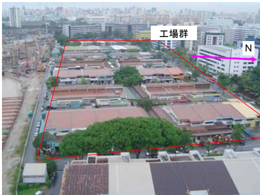
Fig.4 地盤沈下エリア写真
