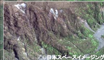
画像2:堆積域と隣接する崩壊地
